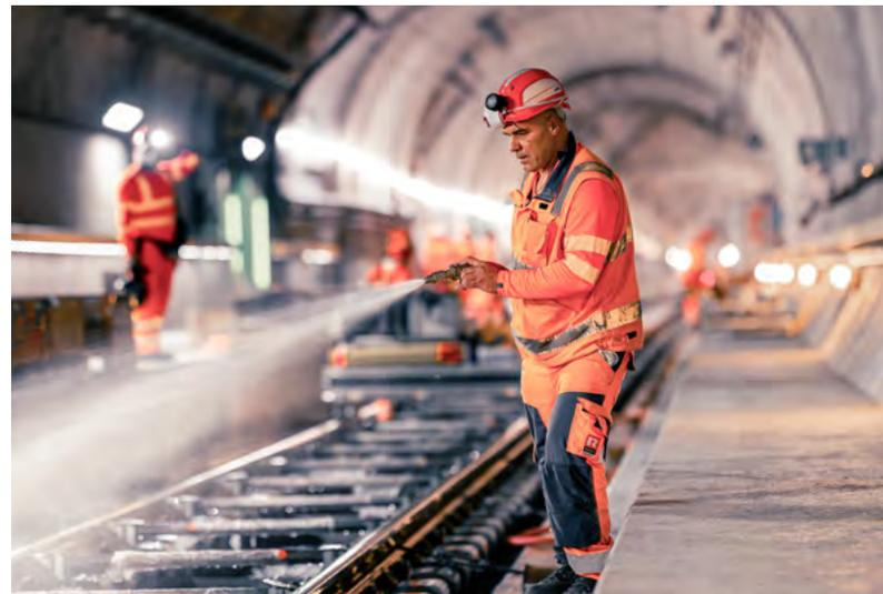
der RSRG dabei von zwei Parteien aus den Reihen von Rhomberg Bau: Sie übernahmen auf der sieben Kilometer langen Strecke die Betonierarbeiten, die für den Einbau der Festen Fahrbahn notwendig sind.
