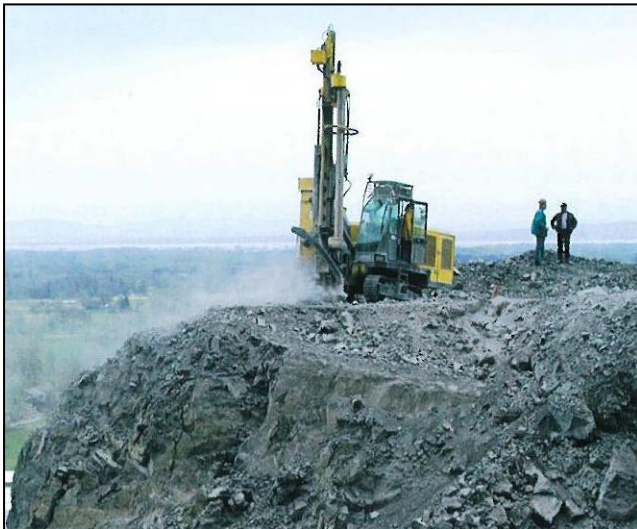
Abb. 132: Arbeiten an der Bruchkante im Jahr 2003
