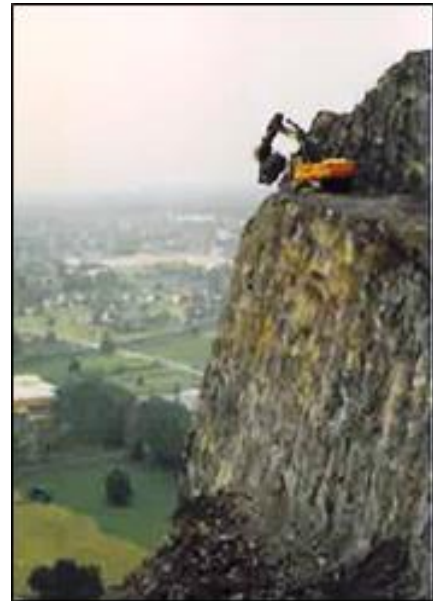
Abb. 90: Bagger auf oberster Etage im Juni 1988
