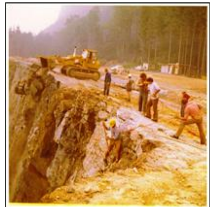
Abb. 57: Nach der Sprengung: Räumung der Abbruchkante mit Laderaupe CAT 983, damals eine der größten serienmäßig produzierten Laderaupen
