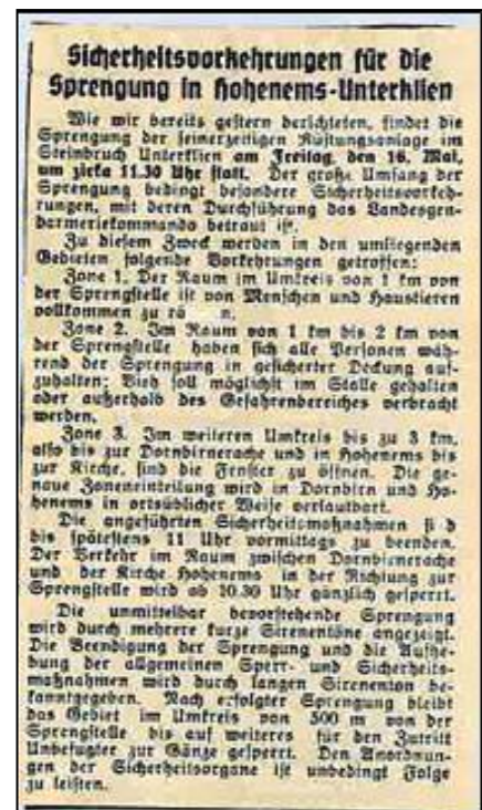
Abb. 41: Zeitungsartikel zur Sprengung des Glaukonit-Werkes am 16.05.1947
