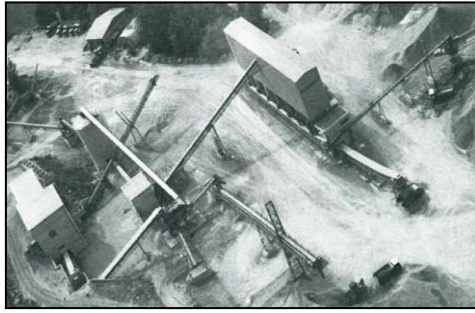
Abb. 82: Vogelperspektive auf Brecher- und Siloanlagen in den 1980er Jahren
