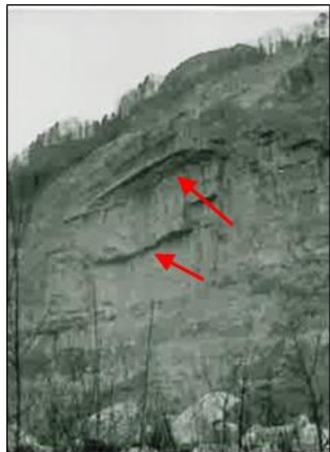
Abb. 58: Zustand vor der ersten und zweiten Sicherheitssprengung, deutlich erkennbar sind die großen Überhänge
