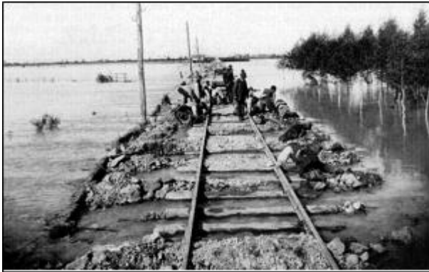
Abb. 17: Überschwemmung der Geleise der Staatsbahnen 1888
