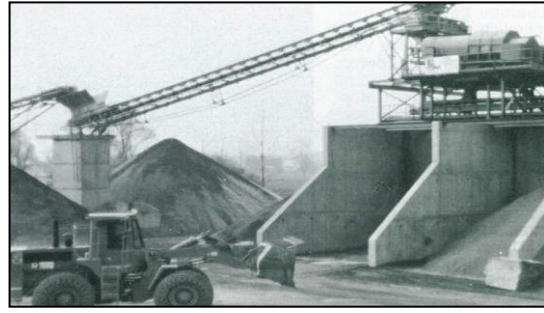
Abb. 83: Waschanlage mit Silobehältern in den 1980er Jahren
