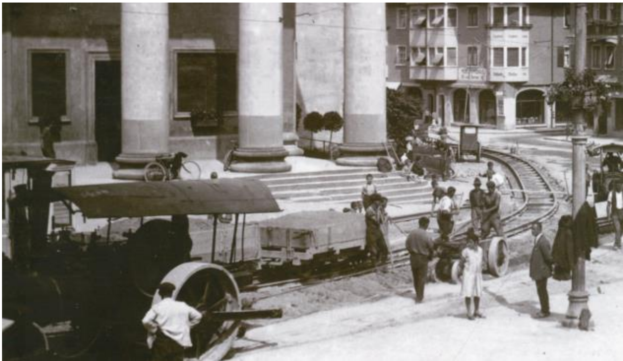
Abb. 33: Dornbirner Marktplatz vor der St. Martin-Kirche – Pflasterung im Bereich der Straßenbahnanlagen. Im Juni 1929 übernahm die Dornbirner Fa. Rümmele den Auftrag für die Pflasterung des Abschnittes „Marktplatz“ um 2,50 Schilling/m 2 , die Fa. Troll lieferte die Pflastersteine um 45,- Schilling pro Tonne vom Steinbruch Unterklien.
