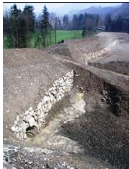
Abb.113: Schutzdamm Breitenberg, nördlich des Steinbruchs Unterklien
