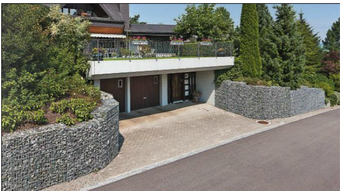
Abb. 117: Steinkörbe, die der Steinbruch in verschiedenen Größen und Formen anbietet, werden im öffentlichen und privaten Tiefbau in vielfältiger Weise eingesetzt.
