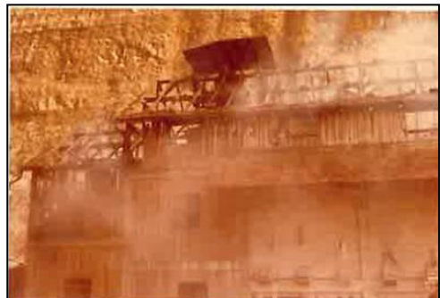
Abb. 75: Brand im Steinbruch Unterklien
