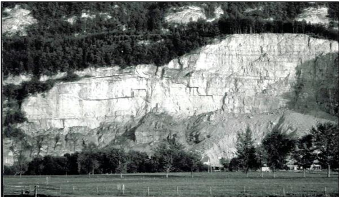
Abb. 51: Steinbruch kurz nach Inbetriebnahme durch die Fa. W. Rhomberg 1970 – erste Sicherheitssprengungen der Gesteinsüberhänge im obersten Bereich bereits durchgeführt
