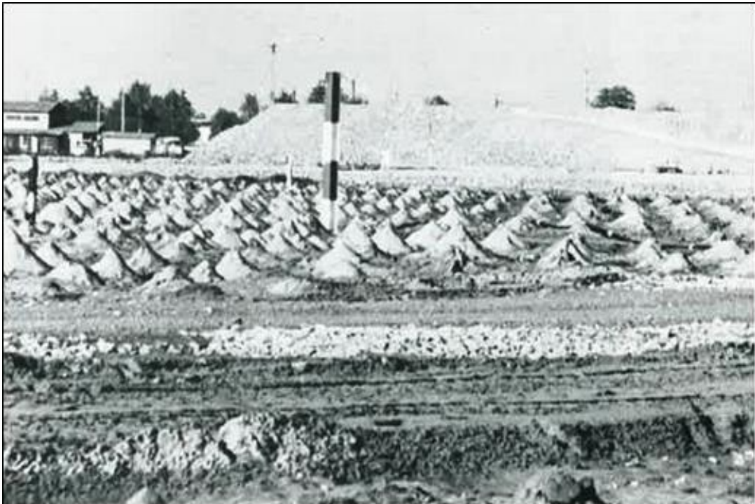
Abb. 71: Verfüllte Vertikaldrains und ein Fixpunkt, im Hintergrund: Auflastschüttung
