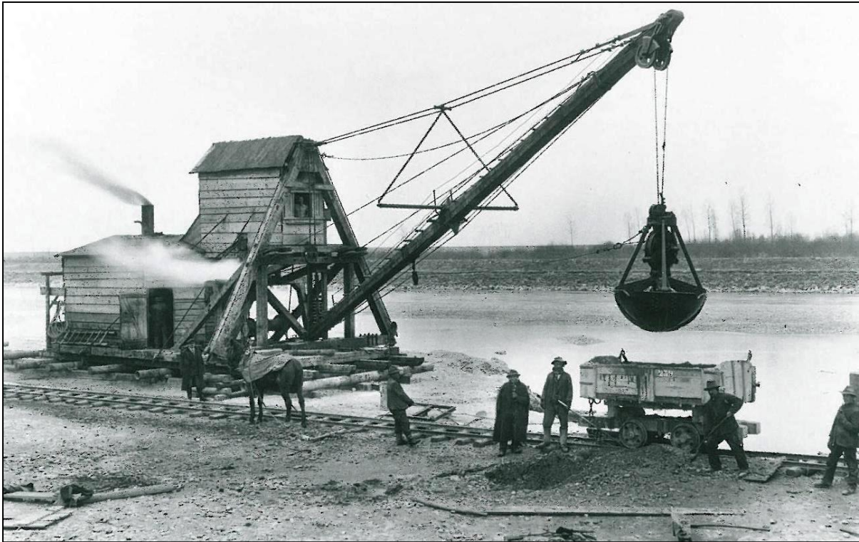
Abb. 21: Kiesgewinnung für Durchstichdämme aus dem Rhein 1911 – Greifbagger bei der Schmitterbrücke
