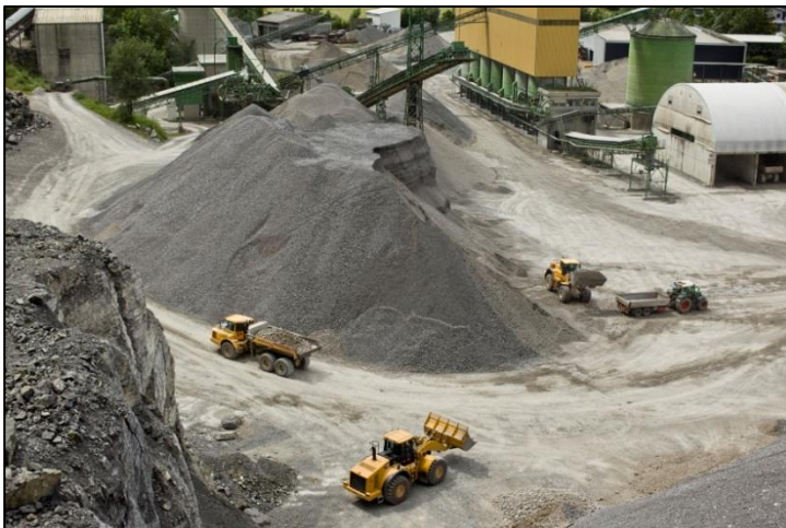
Abb. 130: Depotanlagen – ob Silos, unter Dach oder im Freigelände, sind ein wesentlicher Bestandteil im Steinbruchbetrieb
