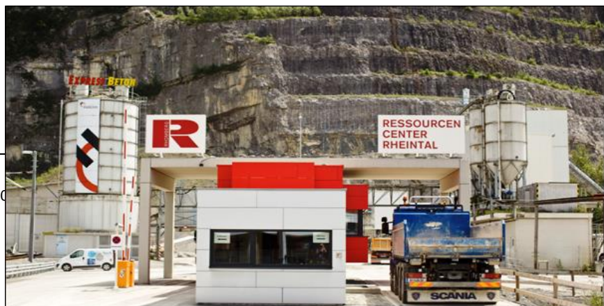
Abb. 125: Neues Waaghaus mit Brückenwaagen für alle An- und Abtransporte
