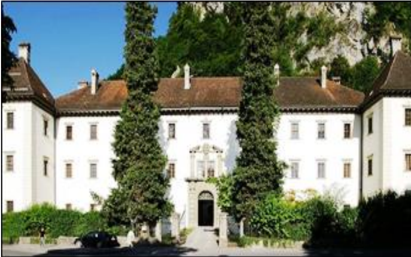
Abb. 47: Palast Hohenems nach der Renovierung 1989
