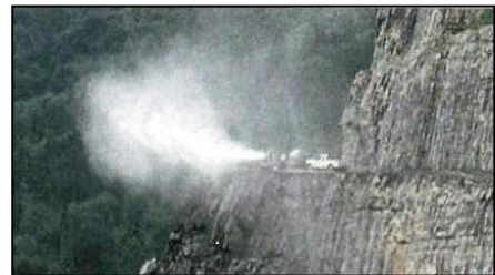
Abb. 114: Umgebaute Schneekanone zur Staubminderung
