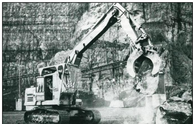
Abb. 80: Steinzangenbagger mit Wasserbaustein
