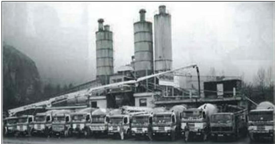
Abb. 84: Expressbetonwerk in Dornbirn; Fahrnischer-Flotte und Betonpumpen
