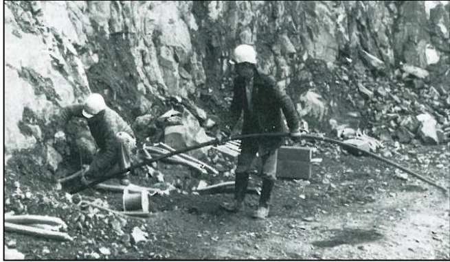
Abb. 78: Tiefbohrlöcher werden mit Sprengstoff geladen und gesichert
