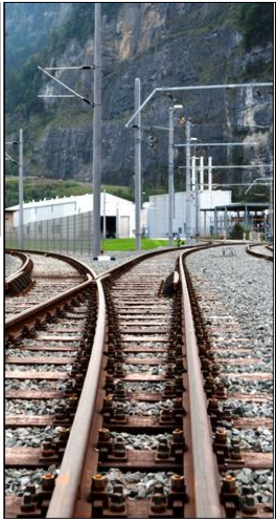
Abb. 158: Der Gleisanschluss ermöglicht den Transport per Bahn, komplett elektrifiziert seit 2009.
