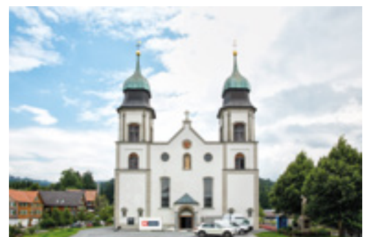
Die Pfarr- und Wallfahrtskirche Maria Bildstein, Vorarlbergs bedeutendster Barockbau, wurde 1676 vom Bregenzer Baumeister Michael Kuen konzipiert und nach 1887 und 1973 von Rhomberg Bau nun zum dritten Mal saniert.
