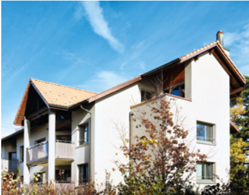
Frisch saniert: Mitten im Grünen gelegen, lässt es sich gut wohnen.
