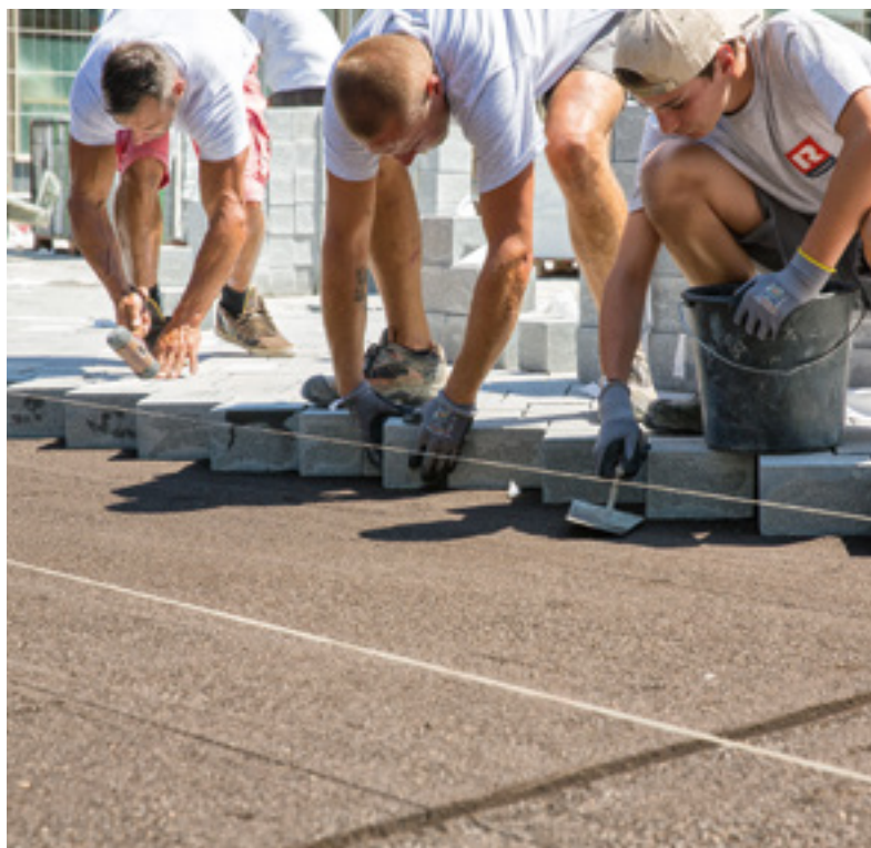
Rhomberg Mitarbeiter bei den Pflasterarbeiten. Zum Einsatz kamen die gleichen dreifarbigten Granitsteine, die schon das Jüdische Viertel schmücken.
