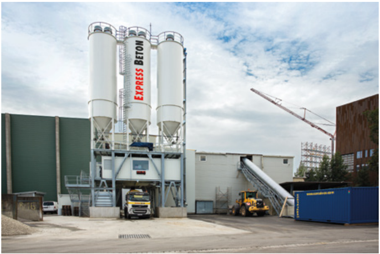
Bequeme Anfahrt für die LKWs und eine Betonmischanlage auf dem neuesten Stand der Technik: Express Beton Werk 2 in Lauterach.
