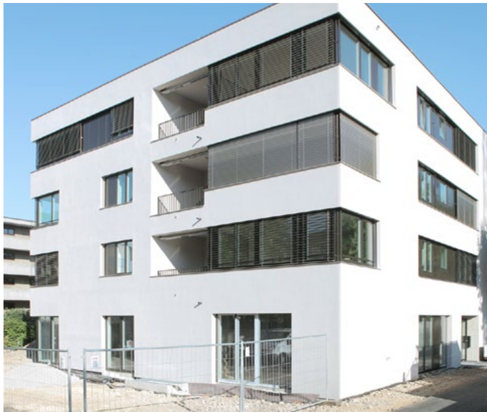
Bietet Platz für alle: Wohnüberbauung „Duradero“, Allschwil.
