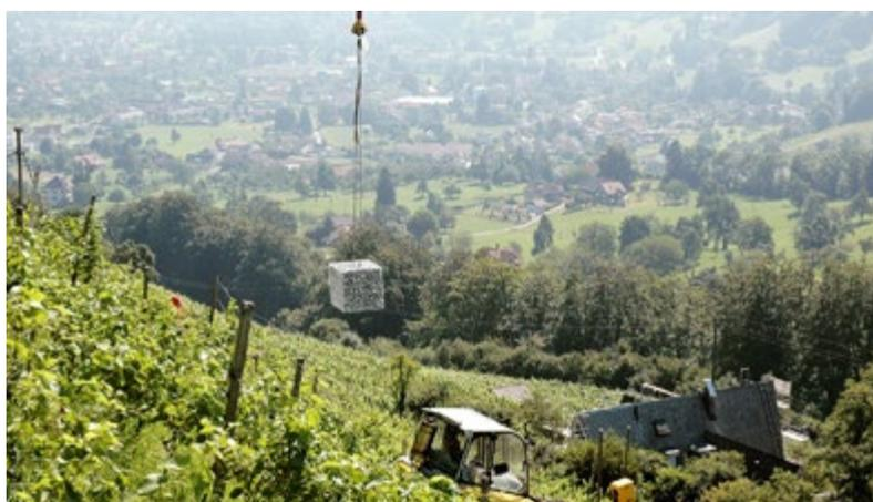
Die Körbe, mit einer Abmessung von 150x100x100 cm und einem Gesamtgewicht von 2.500 Kilo sicher keine Leichtgewichte, wurden mit dem Transporthubschrauber „K-Max“ schnell und passgenau versetzt.
