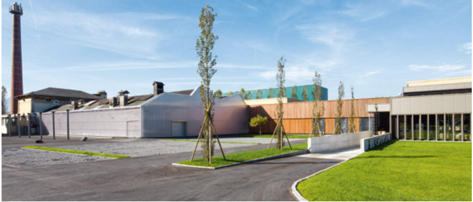
Das Otten-Areal erstrahlt in neuem Glanz. Die Grundlage der Freiflächen besteht aus den alten Gebäuden des Geländes.
