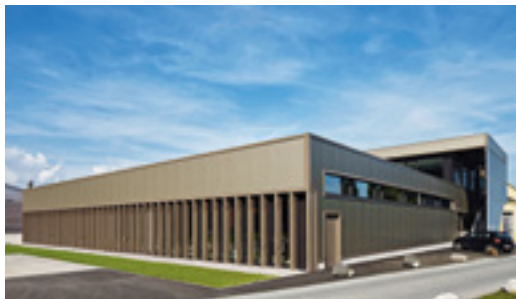
Auch Goldbeck Rhomberg war beteiligt: Die Industriebauspezialisten steuerten die Lagerhalle bei.
