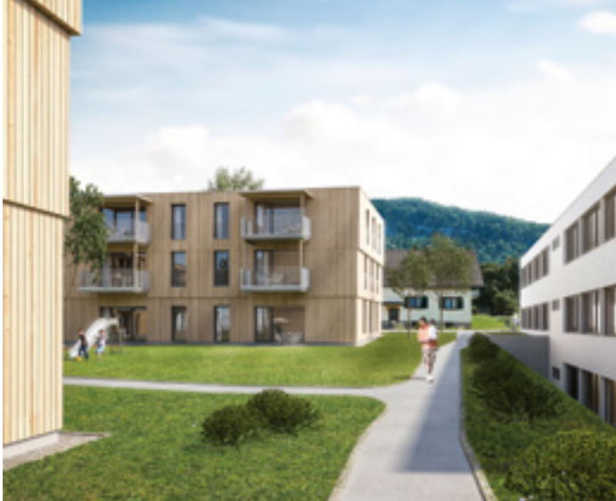
Das Projekt in Götzis steht kurz vor der Fertigstellung.
