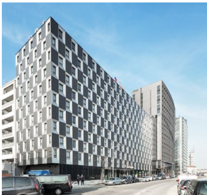
Außenansicht des neuen Star Inn Hotel Premium Wien Hauptbahnhof: hochwertige Eternitfassade mit in Alu gebürsteten Laibungen für die zehn Obergeschosse.
