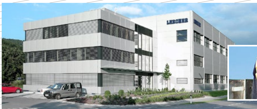
Das Firmengebäude des Werkzeugbauers Lercher in Klaus: eines der ersten Projekte der Goldbeck Rhomberg GmbH.
