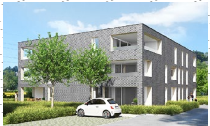
Wohnanlage „Im Schlatt“, Schwarzach
