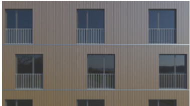
Holzfassade: Fenster vertikal
