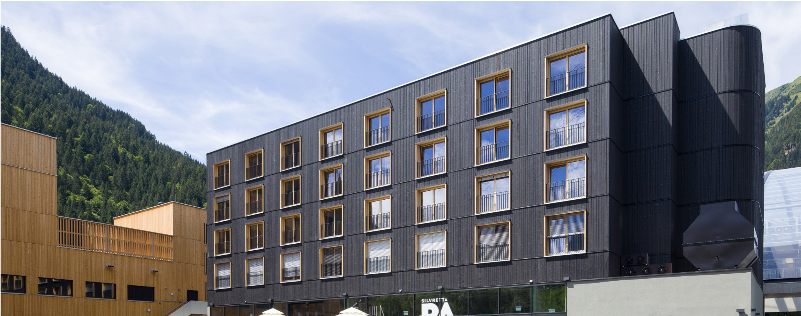
Mitarbeiterhaus - SIMO St. Gallenkirch
