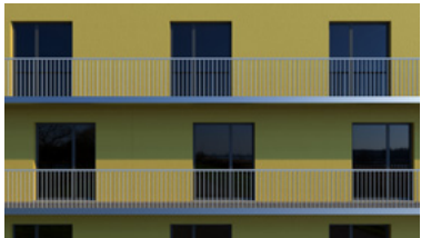
Verputzt & Farbe: Balkonband
